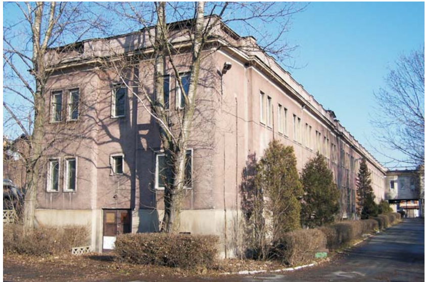
Foto 3 Widok elewacji szpitala skrzydło dłuższe z drogi wew.na terenie nieruchomości - w głębi widoczny przejazd pomiędzy skrzydłami
