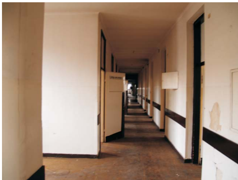
Foto 5 Korytarz na 1 piętrze skrzydła dłuższego budynku szpitala
