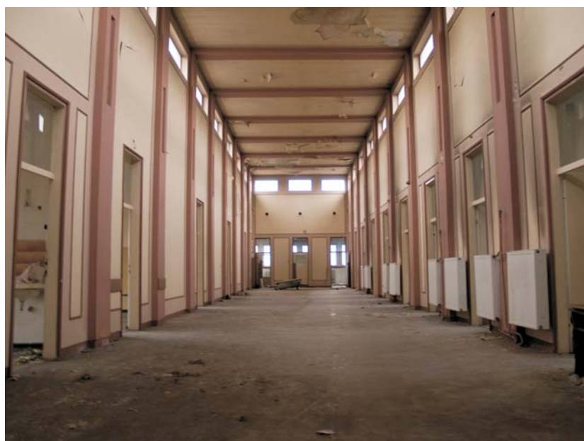
Foto 6 Pomieszczenie w skrzydle bocznym na 1 piętrze o niestandardowej wysokości
