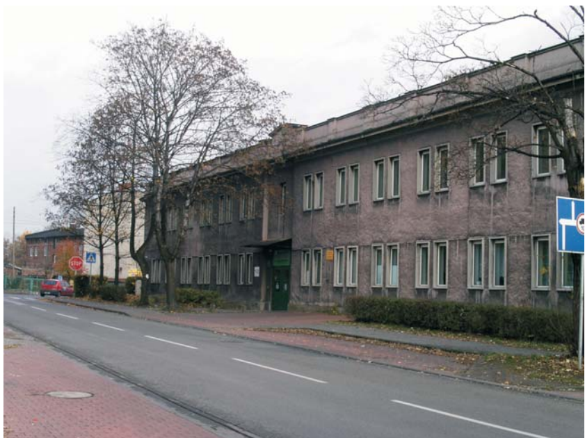
Foto 4 Fragment elewacji szpitala skrzydła dłuższego od strony zachodniej
